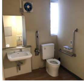
多目的トイレ
