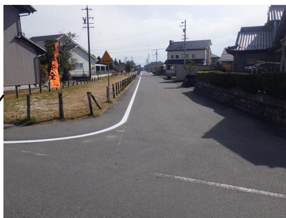
完成後の様子
